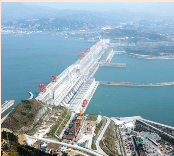
Fotografia da Usina de Três Gargantas (2009), na província de Hubei, na China, que com 26 turbinas fornece uma potência total de 18 200 MW, maior que os 14 000 MW de potência instalada de Itaipu. É um projeto controverso que inundou importantes sítios arqueológicos e demoveu 1,1 milhão de pessoas, muito embora tenha colaborado para controlar enchentes no Rio Yang-Tsé.
